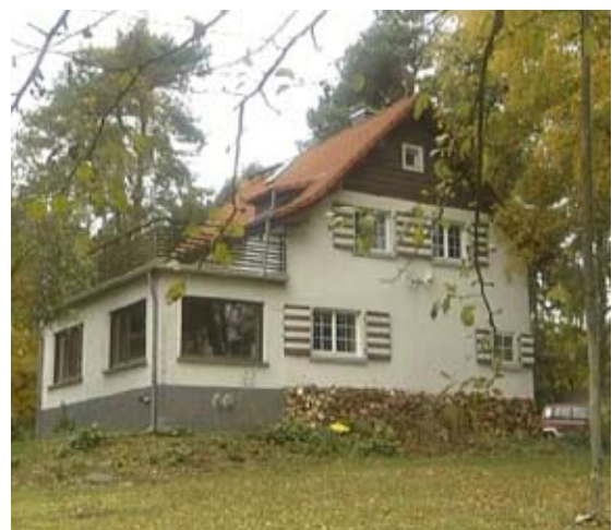
Öko-Förster Wohlleben berät die Pellet-Heizung seines Häuschens
